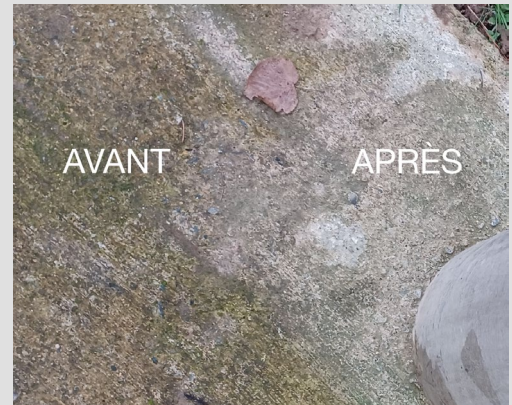
Test sur sol en béton
